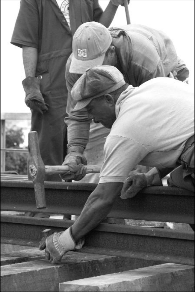
Para recuperar la infraestructura ferroviaria se requiere fuerza laboral especializada. Foto: Ismael Batista
