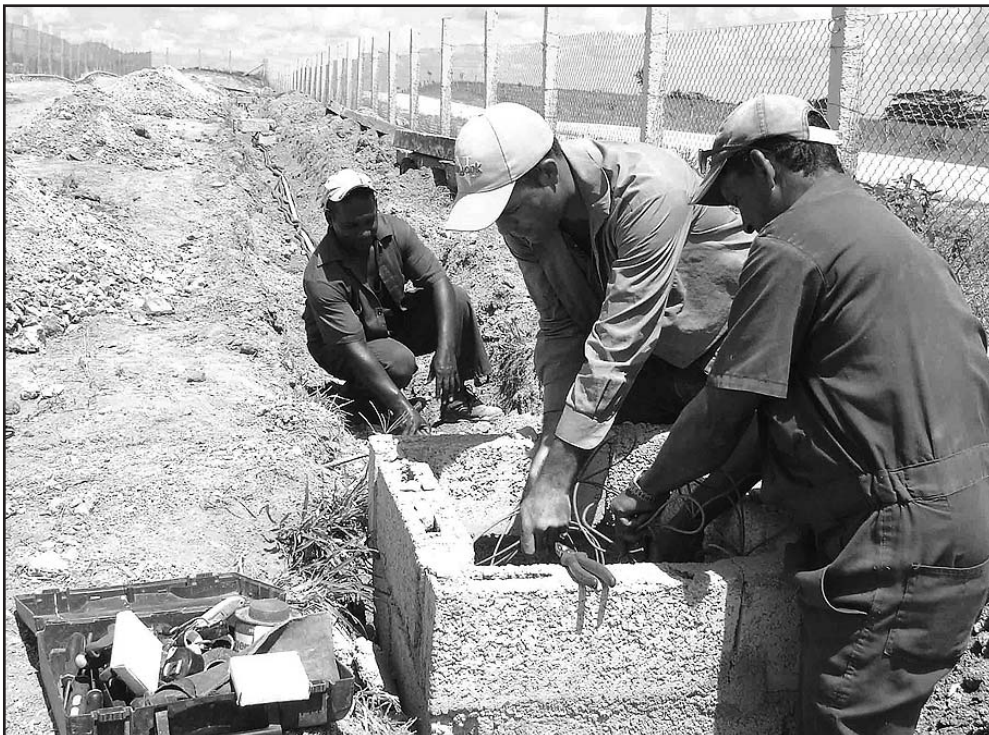
Fernando, Yusel y Yosvani forman parte de la brigada de Villa Clara que participa en la remodelación de la cantera.
