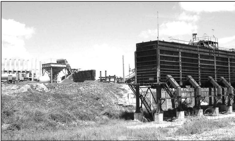
Parte de las instalaciones antiguas armonizarán con el nuevo equipamiento en pos de una mayor producción. Fotos: Jorge Luis Téllez
