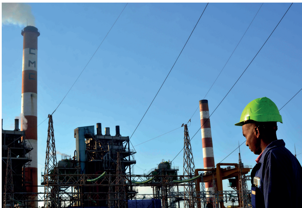
En la termoeléctrica de Cienfuegos continúa la reparación de las dos unidades. FOTO: MODESTO GUTIÉRREZ
