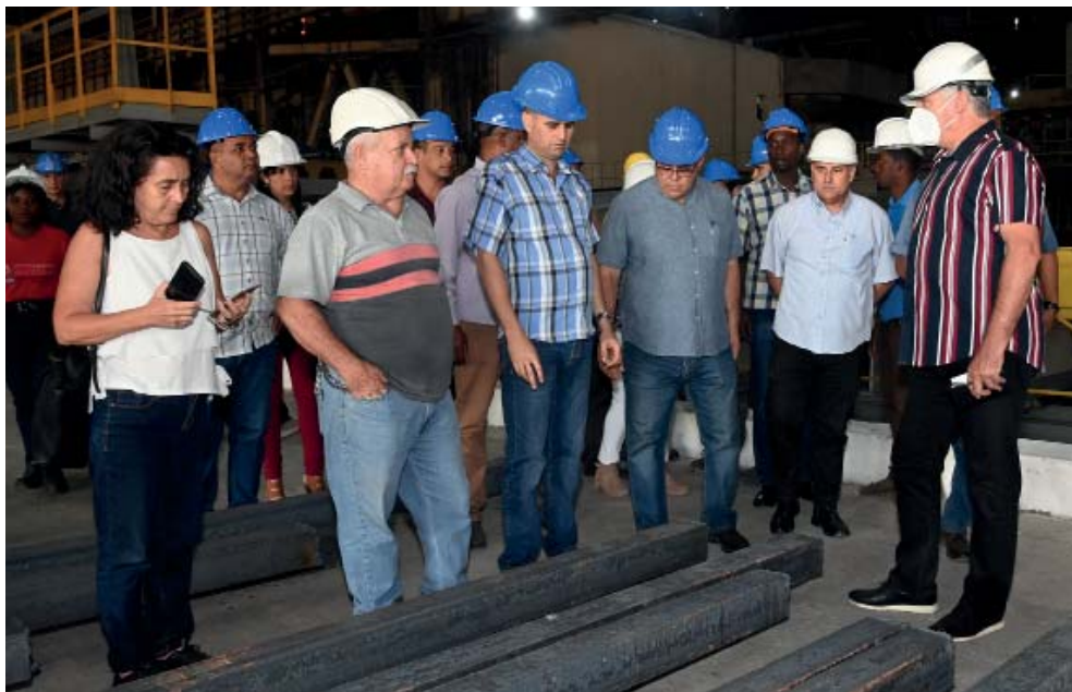
Además de reanimar la producción siderúrgica, Antillana de acero impactará sensiblemente en la construcción. FOTO: ESTUDIOS REVOLUCIÓN
