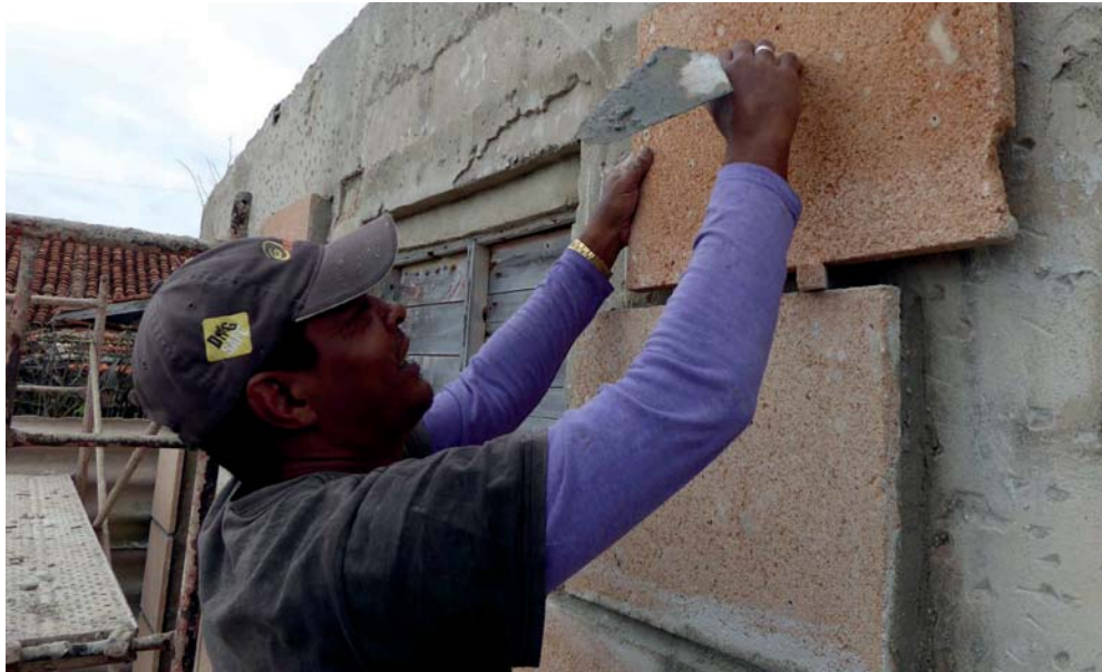
Este año está planificado construir en Holguín 2 312 viviendas. FOTO: GERMÁN VELOZ PLACENCIA
