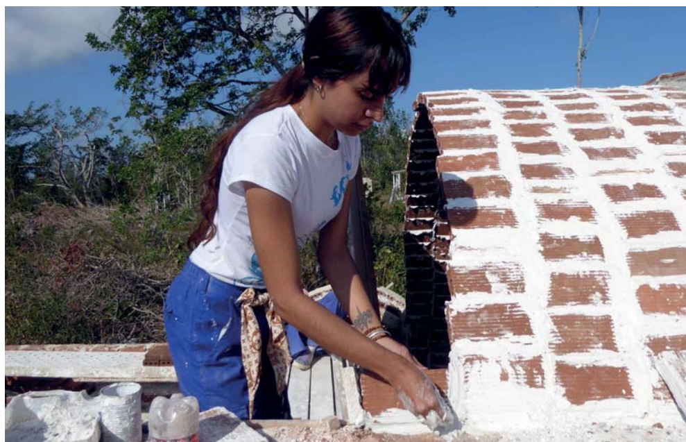
Julieta espera que esta construcción sirva para motivar a los habitantes de Viñales a utilizar una técnica con importantes virtudes. FOTO DEL AUTOR
