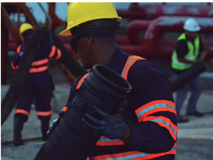
En la instalación de los equipos de mayor potencia para el bombeo de agua y espuma, a fin de combatir el incendio, trabajan mancomunadamente técnicos cubanos, mexicanos y venezolanos. FOTO: RICARDO LÓPEZ HEVIA
