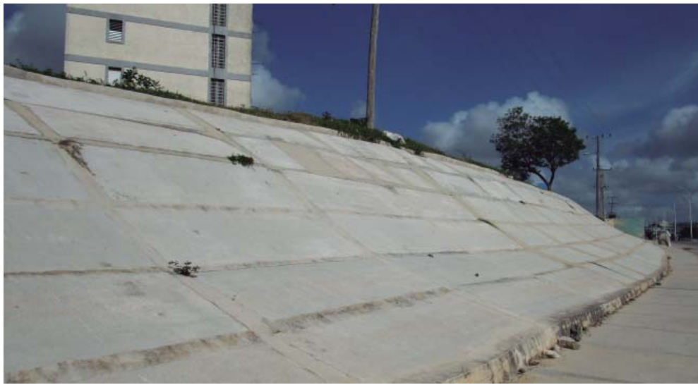
Emplear losas de concreto en un tramo de la Carretera Central que atraviesa la ciudad de Holguín fue una solución muy criticada, porque, si bien evita la erosión, contribuye a elevar la temperatura ambiente.
