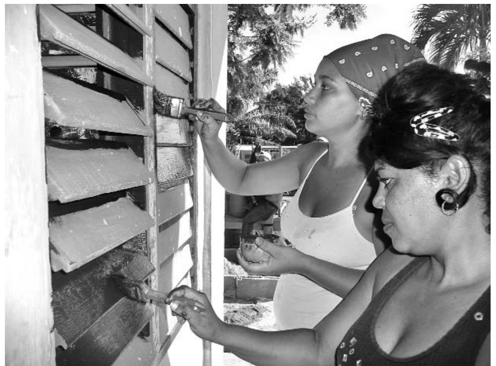
Trabajadoras de la escuela Indalecio Montejo dan los toques finales a las aulas. FOTO DEL AUTOR
