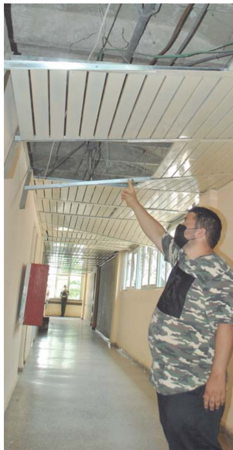
El falso techo en el interior del hospital muestra evidencias de la fuerza del temblor.
