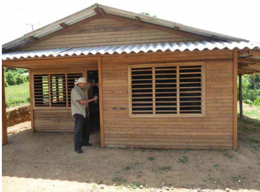
La vivienda en construcción de Luis Felipe Guilarte, ubicada también en La Cuchilla, no corresponde al programa con participación estatal, pero es una muestra de cómo trabajar la tabla de palma con estética. Todas las tablillas tienen ocho centímetros de alto.
